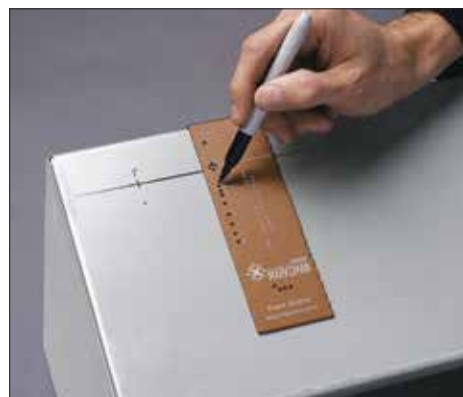
STEP 3 MARQUE EL CENTRO DEL KNOCKOUT Y TALADRE
